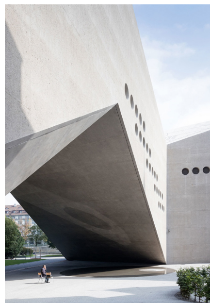
Figure 7: Actelion Business Center, Allschwil, Svizzera, 2010, progetto architettonico Herzog & De Meuron, progetto strutturale Schnetzer Puskas Engineers. Immagine tratta da A. Flury, Schnetzer Puskas, Design Structure Experiences (Zürich: gta Verlag, 2013).
