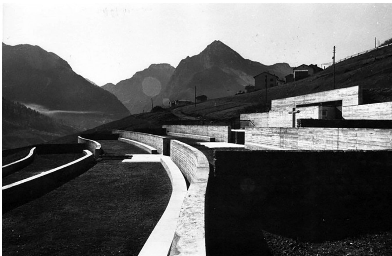
Fig. 10 Cimitero di Erto a Monte. L'interno, con la successione dei terrazzamenti per le sepolture a terra. L'andamento curvilineo dei muri di tenuta accompagna l'orografica del versante. L'Architecture d'Aujourd'hui 170 (1973).
