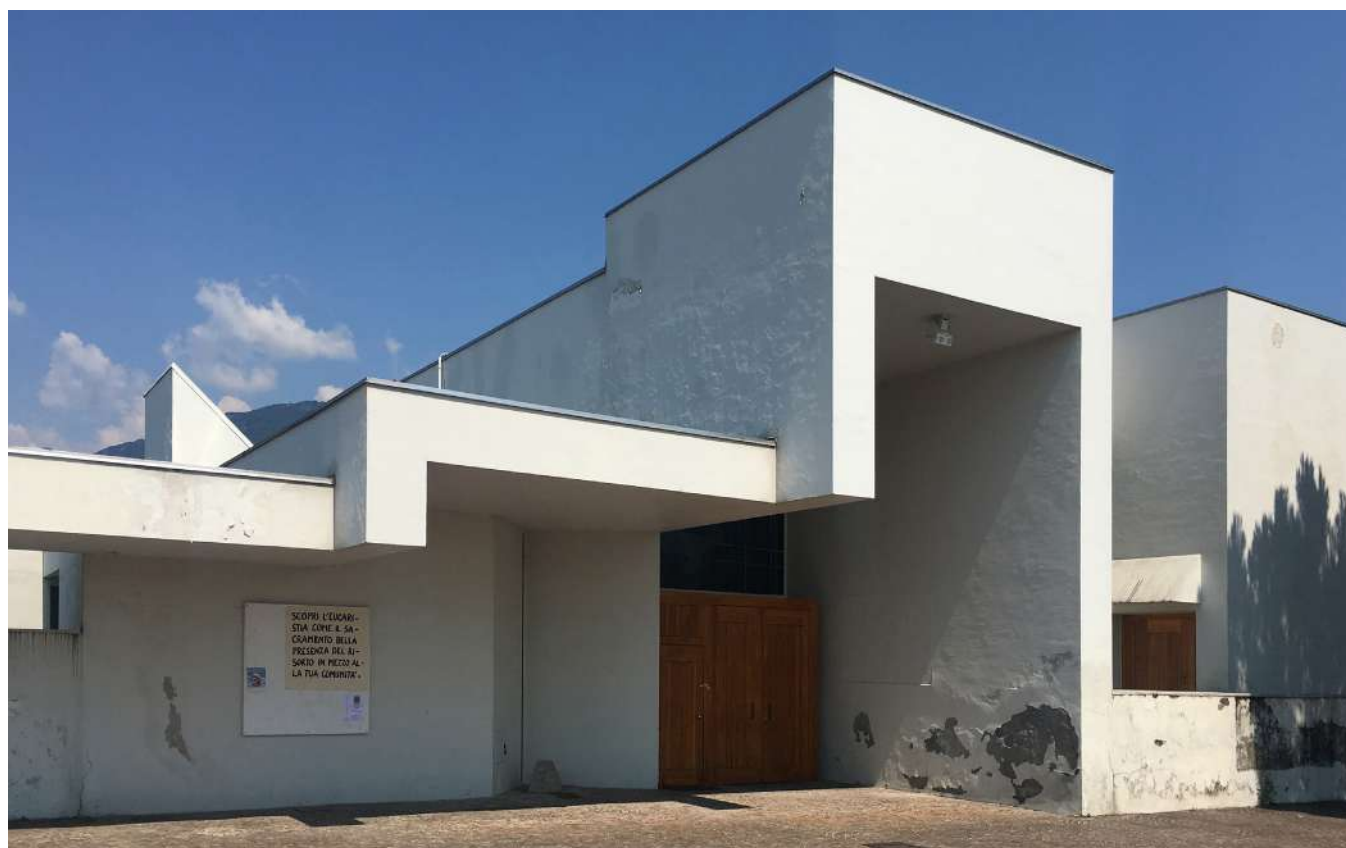
Figg. 9–10 Chiesa e opere parrocchiali di Vajont. Particolare dell'ingresso alla chiesa.
