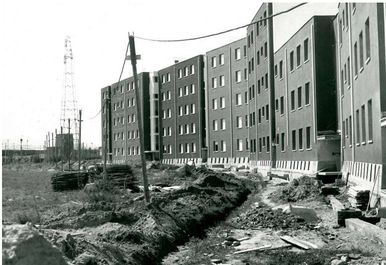
Fig. 6 Cantiere dell'edificio di Glauco Gresleri al Pilastrò, 1965. Archivio privato di Glauco Gresleri.
