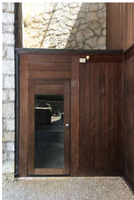
Fig. 4 Cimitero di Vajont. Particolare del tamponamento in legno e di un serramento della cappella.
