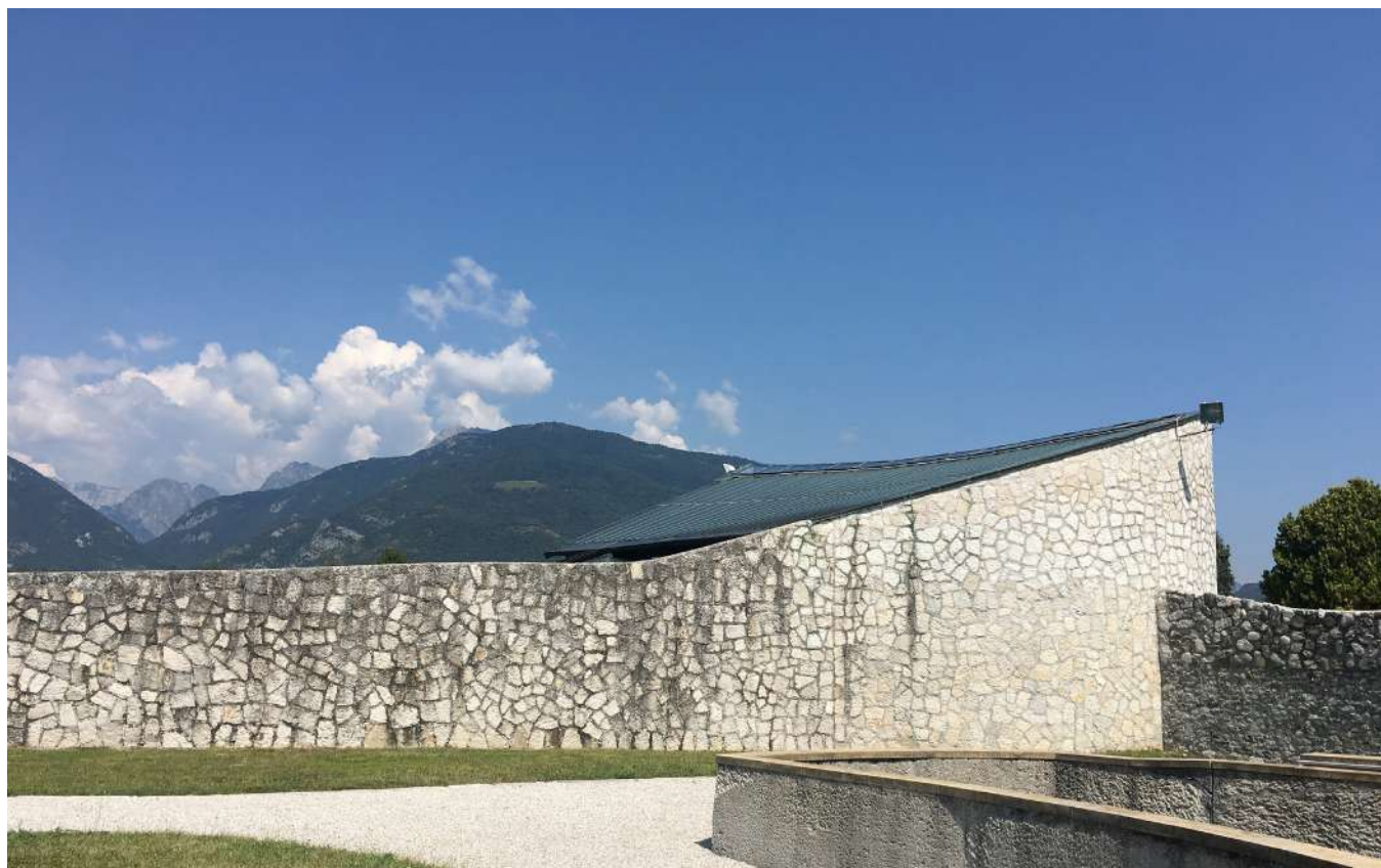
Fig. 1 Cimitero di Vajont. La cappella dall'esterno.
