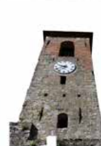
Vista esterno D
