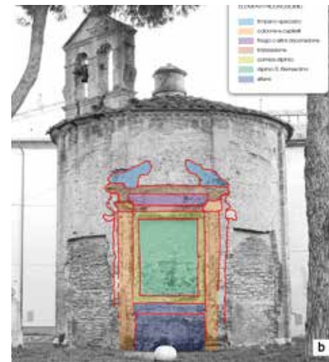
Fig. 3(in basso) Il fronte Nord-Ovest con, in evidenza, le tracce della navata rettangolare (a) e di un altare con ciborio (b)
