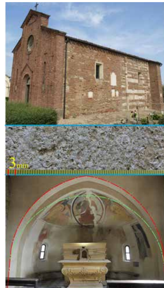
Fig. 7 Buttigliera (AT), antica località di Mercuriolium, S. Martino. Scorcio su fronte e lato sud, macrofotografia della calcarenite di riuso adoperata (con scala millimetrica di riferimento), interno abside.
