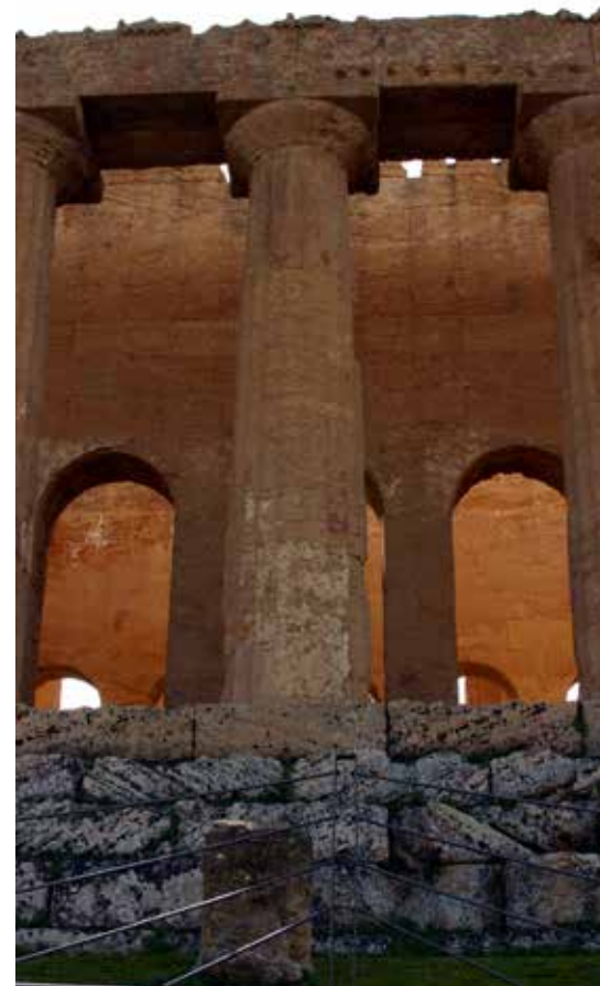
Fig. 7 Dietro il peristilio del tempio agrigentino si intravedono le pareti del naos, bucate per permettere la comunicazione tra le navate della basilica bizantina
