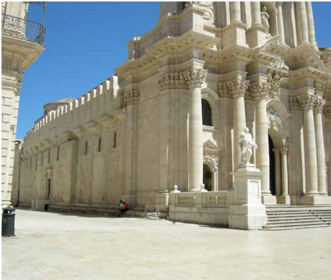
Fig. 1 La facciata principale del Duomo di Siracusa: si noti il contrasto tra l'impaginato barocco e i resti del colonnato laterale dell'Athenaion
