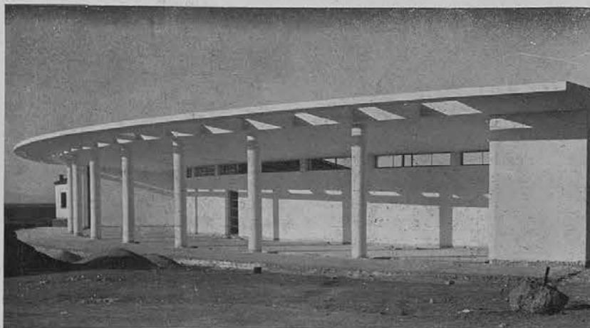
FAÇADE SUD, CAISSONS DE L'AUVENT ENLEVÉS
