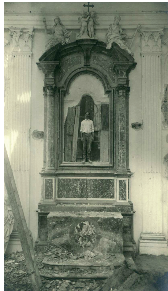
Fig. 5 La chiesa di S. Filippo in fase di demolizione, 1900 c.: ASICAP (Archivio Storico Iconografico della Civica Pinacoteca), raccolta di foto del monastero di S. Filippo (XIX-XX secolo)
