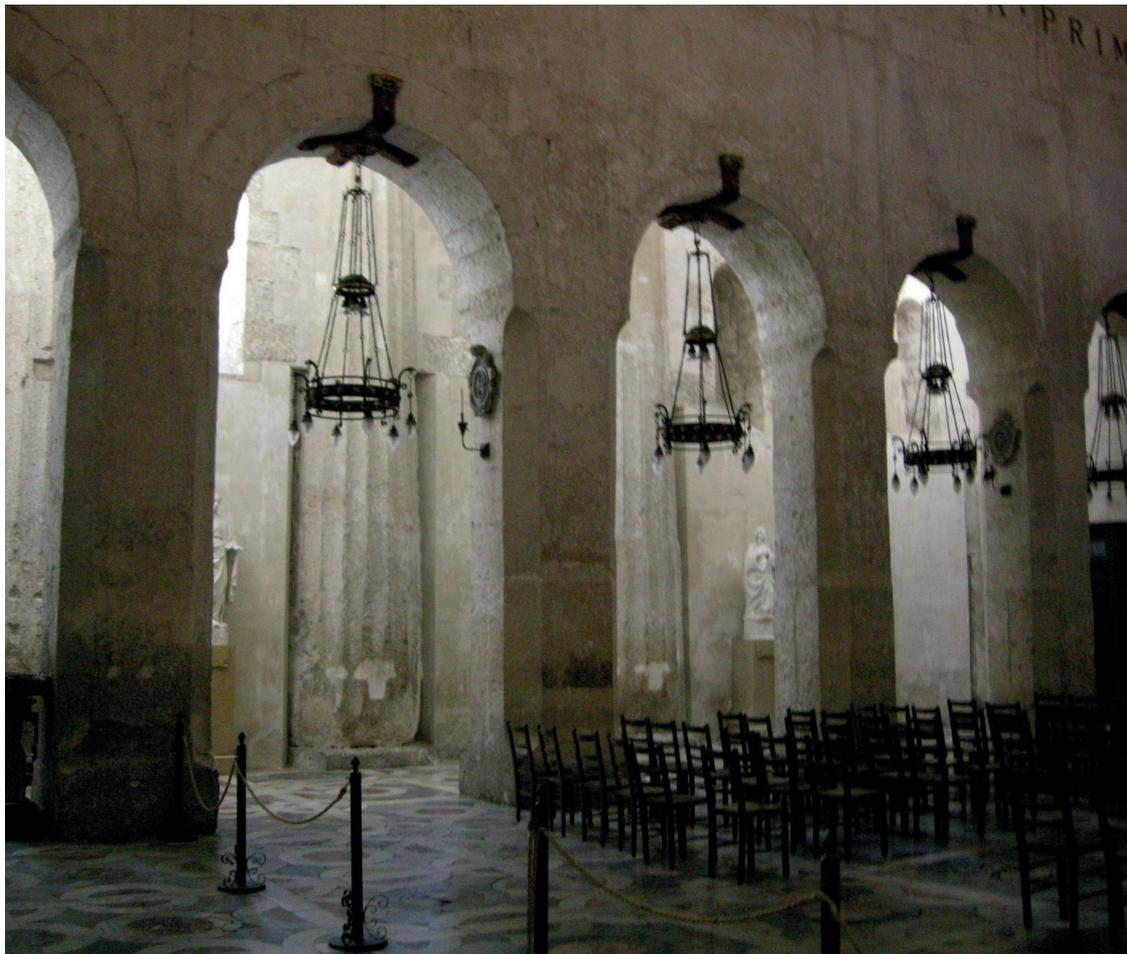
Fig. 3 Le pareti della cella del tempio greco aperte dalle arcate e che permettono la comunicazione tra la navata centrale e quella settentrionale
