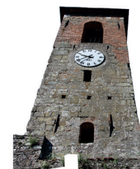
Vista esterna D
