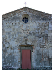
Vista esterna A
