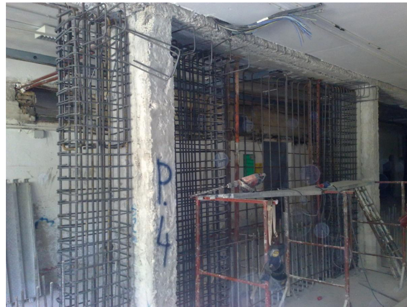
Fig. 17 - posizionamento dei setti all'interno della maglia strutturale dell'edificio.
