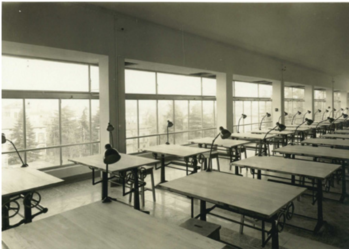
Fig. 9 – La vetrata continua dell'aula di disegno (Archivio Storico della Regione Emilia Romagna).
