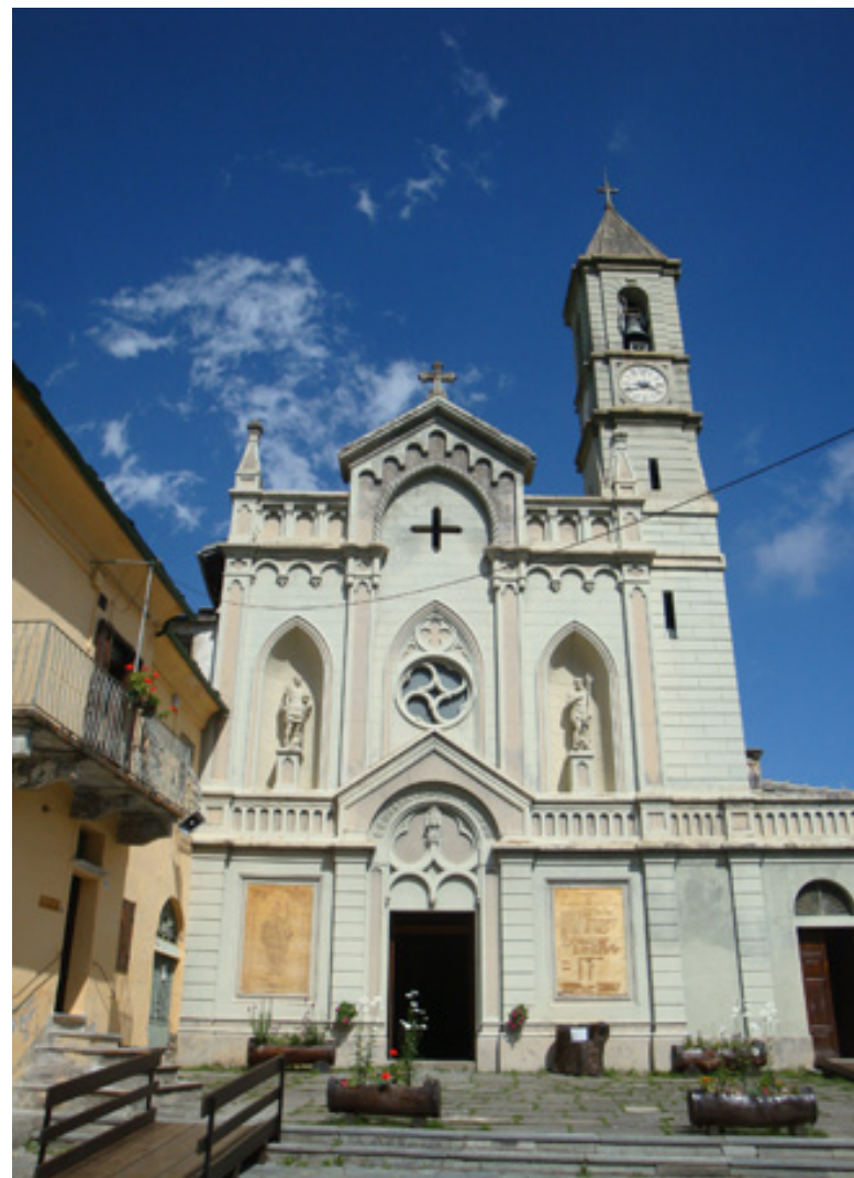
Fig. 3 - Chiesa di S. Chiaffredo, Crissolo (CN). Le soluzioni per il superamento delle barriere architettoniche presenti sul sagrato sono realizzate in legno e si armonizzano con il circostante paesaggio di montagna.
