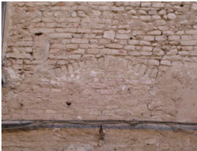
Fig. 1 – Le fasi dell'evoluzione dell'edificio letta tramite la differenziazione tra murature realizzate in epoche differenti: si nota l'uso di materiale eterogeneo nella porzione più alta, identificata come la più antica (foto di G. Predari).
