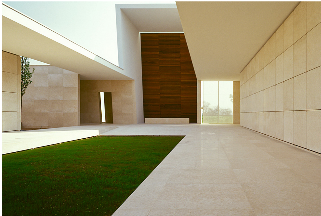
Fig. 8 - Ampliamento del Cimitero di Bagnolo Mella. Interno.
