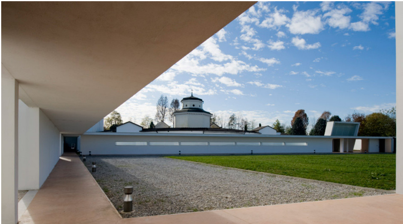
Fig. 10 - Addizione nel cimitero di Montirone.
