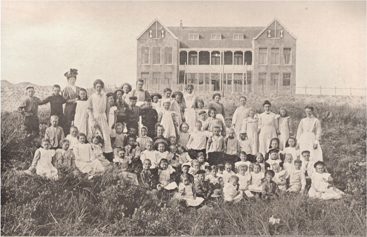
KOLONIE VAN HET CENTRAAL GENOOTSCHAP TE EGMOND A. ZEE. OP DEN ACHTERGROND DE VOORGEVEL VAN HET KOLONIEHUIS „KERDIJK”.
