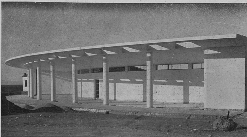
FAÇADE SUD, CAISSONS DE L'AUVENT ENLEVÉS
